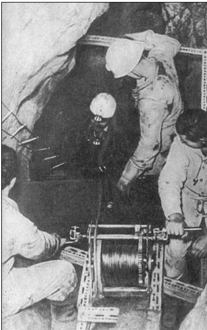
Над Черным колодцем установлена платформа с лебедкой
